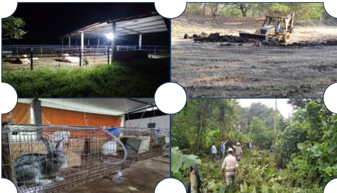
Anexo 17.- Actividades de mantenimiento de infraestructura en el CUTT San Ramón.
